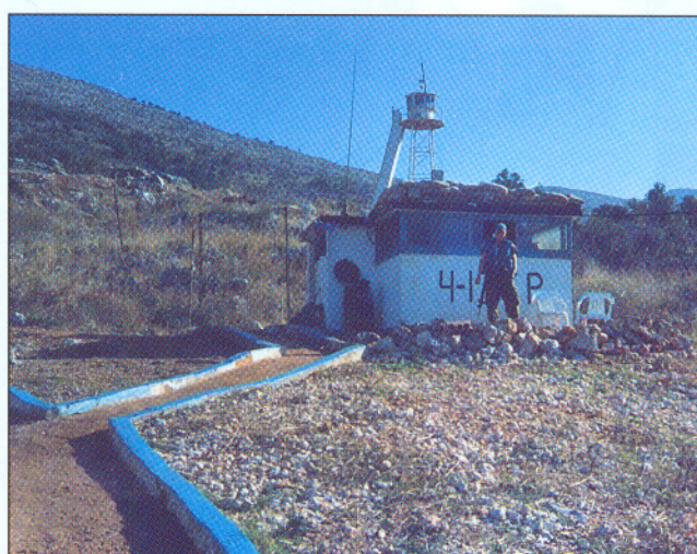
Sikringshuset og OP tårnet i 4-13 CP/LL.
