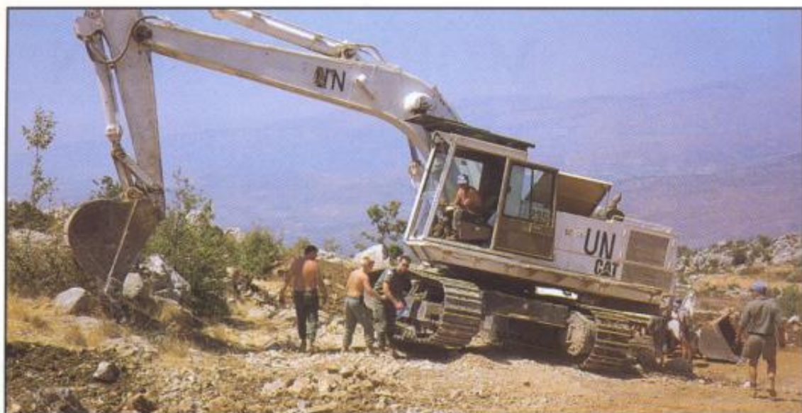
Inspeksjon av Ingeniør materiell på Sveaveien. Korp Hagen, Fenr Holsen og Menig Laupstad. (foto: Sture Helander)
