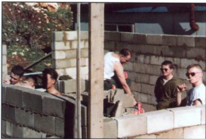
Innsatsvilje! Joda, det har vi! Her skal vi bygge tørke/trimrom i 4-25 LL. Dette skal gjøres ved egen innsats. Bygget er ferdig, unntatt taket som bataljonen skal sette opp.
