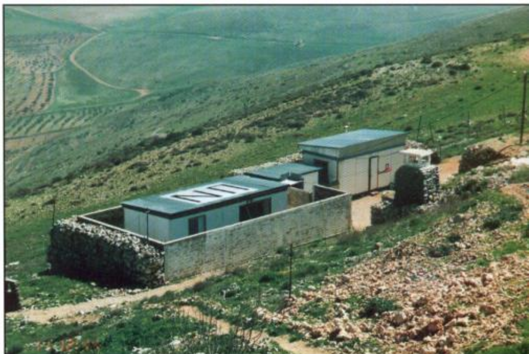
Soveprefab + oppholdsprefab 4-23 OP.
