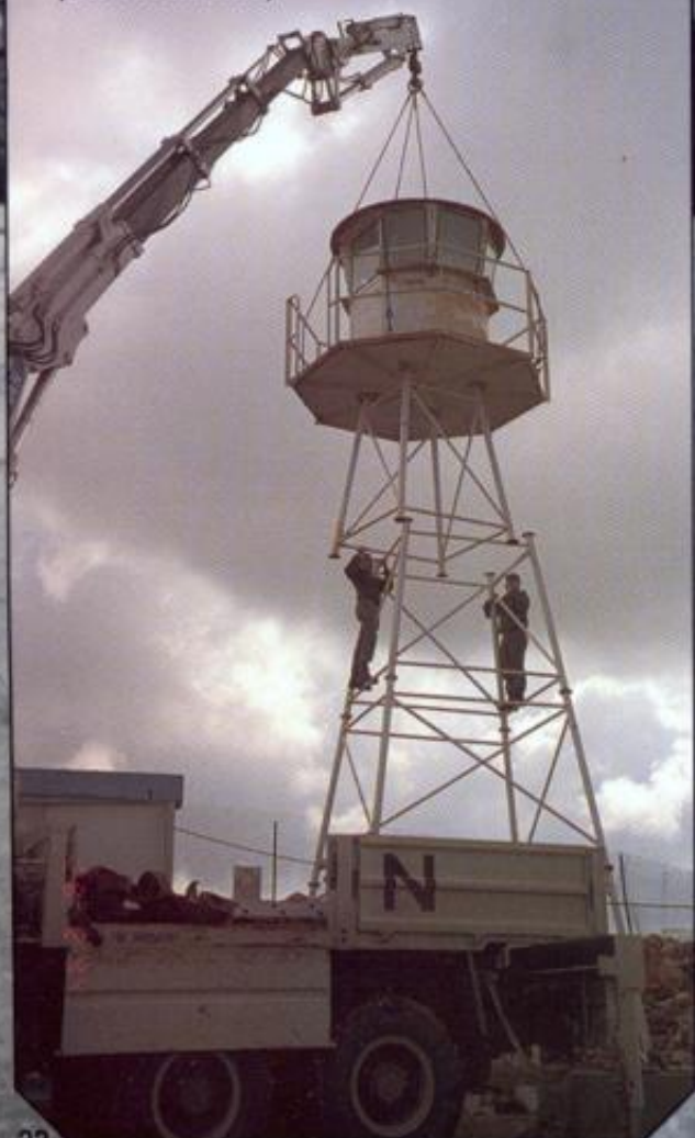
Posisjon 5-11c, NEPBATT, montering av OP tårn. T.h. Rasmus Erøybakk, Gustavson fra SWEDLOG. (foto: Are Nordhus)
