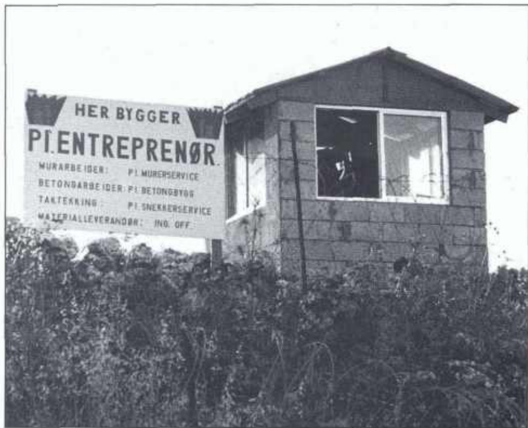
Ingen tvil om at det er Pitroppen som står bak det utmerkede håndverksarbeide bygverket ved siden av representerer. Dette er et nytt, kombinert vakt- og OP-tårn i 4-25 lagsleir.
