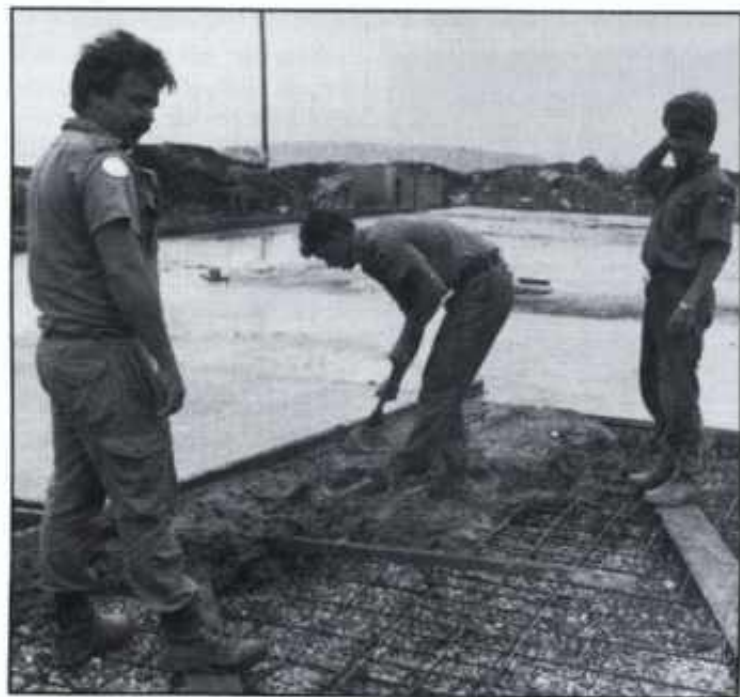
Det gikk med 170 tonn ferdig betong til å støpe gulvet til vedlikeholdshallen i den nye Mekleiren. Syv-åtte mann fra Pitroppen og Mektroppen gjorde jobben på noen få dager med to små sementblandere. Vannbilsjåførene som fraktet alt vannet må heller ikke glemmes. (Foto: Alf Lervik)
