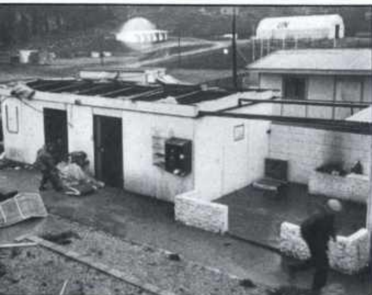
Takplatene på en prefab'ene på Steinmyra blåste i den kraftige vindbyggen som kom foran uværet 14 februar. (Foto: Finn Eig)
