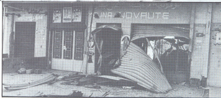
Dette var en butikk. Nå er butikken og fasaden totalt ødelagt.
